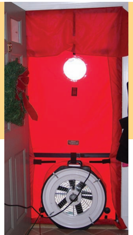
A Blower Door Diagnostic Test
